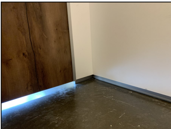
Configuration toute-hauteur avec barre GS 40-1300 à indicateur LED
